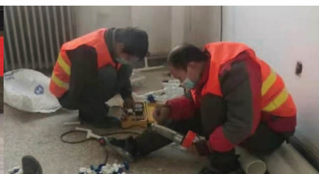
石家莊疫情隔離點施工改造
